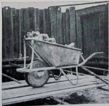
Fig. 92. Stalen mortelkruiwagen (80 l inhoud)
