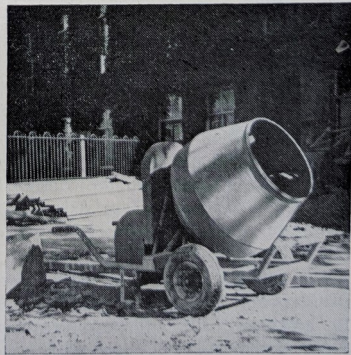
Fig. 91. Speciemolen, tevens betonmolen.
